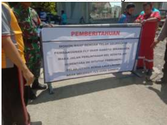
Penutupan Jalan Tengah JPL
