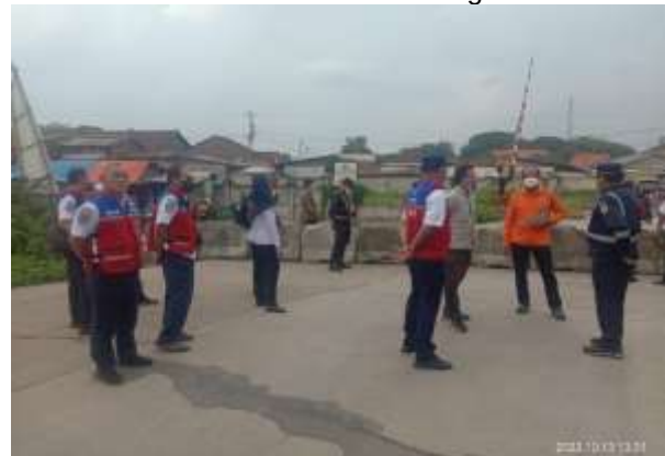
Pemasangan MCB Beton
