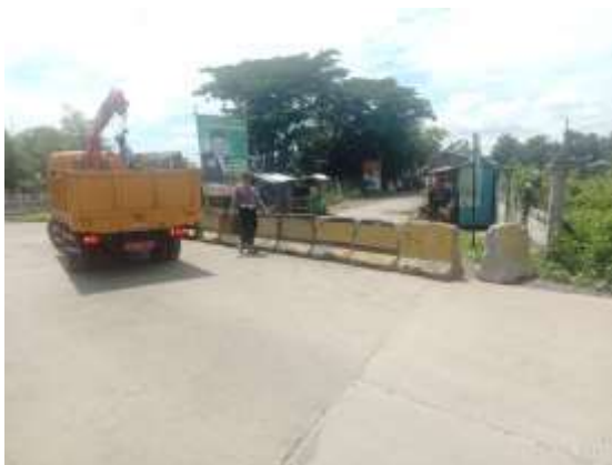
Pemasangan MCB Beton
